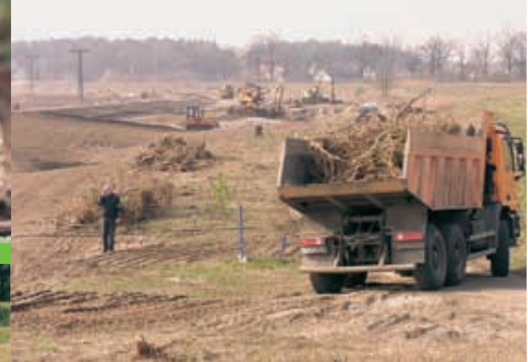
04 Beginn der Baumaßnahmen im März 2004
